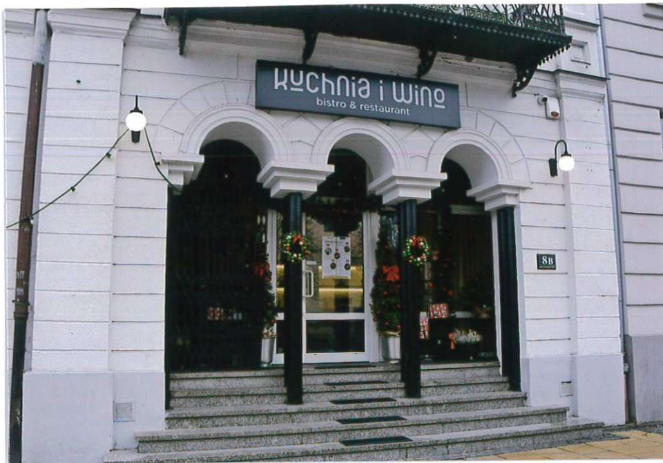
Fot. 2. Przyziemie ryzalitu południowej elewacji frontowej.
